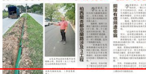
在馬六甲東區中區區議會轄下，李富豪（左）與區議員（右）視察新架坡路電線更換工程。
